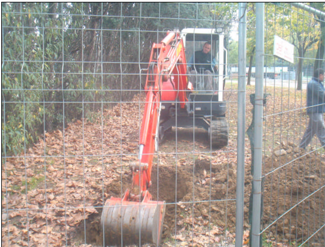
Figura 10. Una fase di esecuzione di un saggio (S10).
